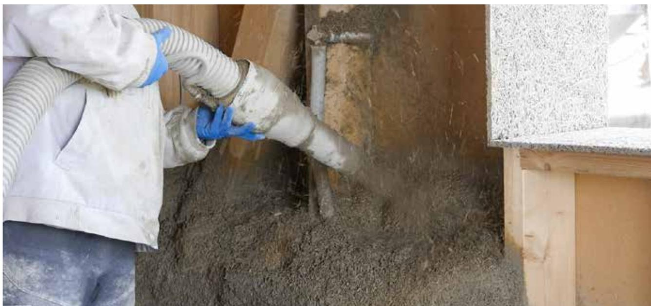
Die Hanf-Kalk-Mischung wird mit einer speziellen Spritzmaschine auf die einseitig geschaltete Wand aufgetragen.
