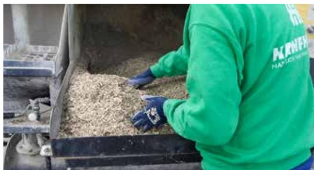
Hanfschäben, Kalk und Wasser werden bei dem Sprühverfahren vor Ort auf der Baustelle maschinell verarbeitet.
